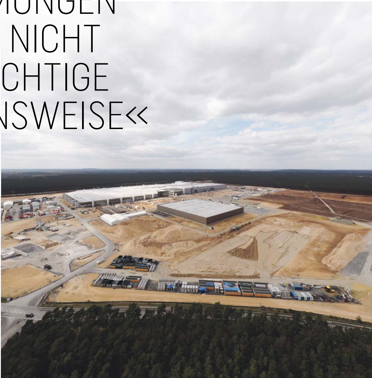
Die Baustelle der Tesla-Gigafactory in Brandenburg im April 2021. Das Projekt rief Proteste hervor.
